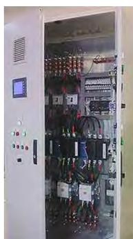
Р и с у н о к 14.4.1. Шкаф автоматики станции биологической очистки, предназначен для управления насосами со стандартными асинхронными двигателями.
